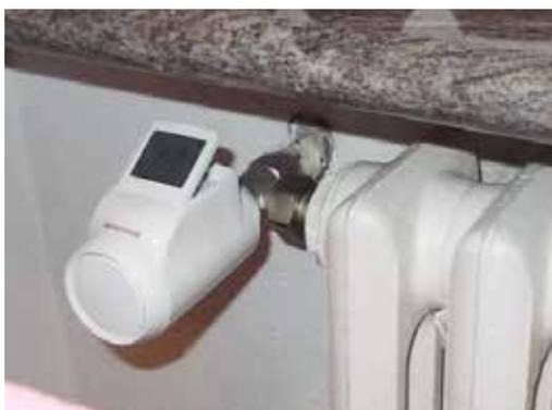
Il regolatore motorizzato HR92 applicato alle valvole termostattizzabili Honeywell
