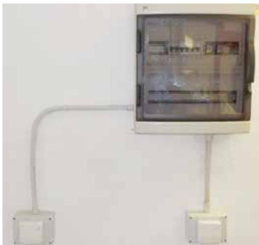
Quadro elettrico in locale caldaia e relè wireless DBR91 per azionare la caldaia e la pompa :
