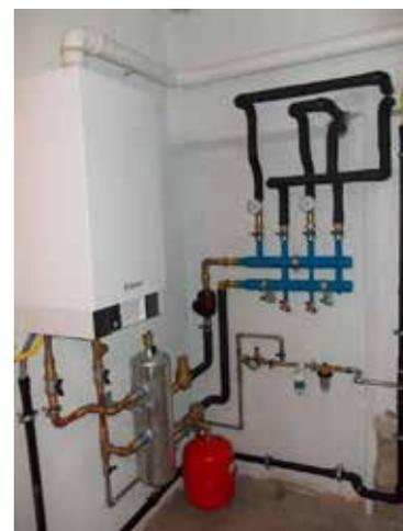
Locale caldaia: da notare la riduzione ai minimi termini della componentistica: una sola pompa a portata variabile, nessuna valvola di zona ulteriore:
